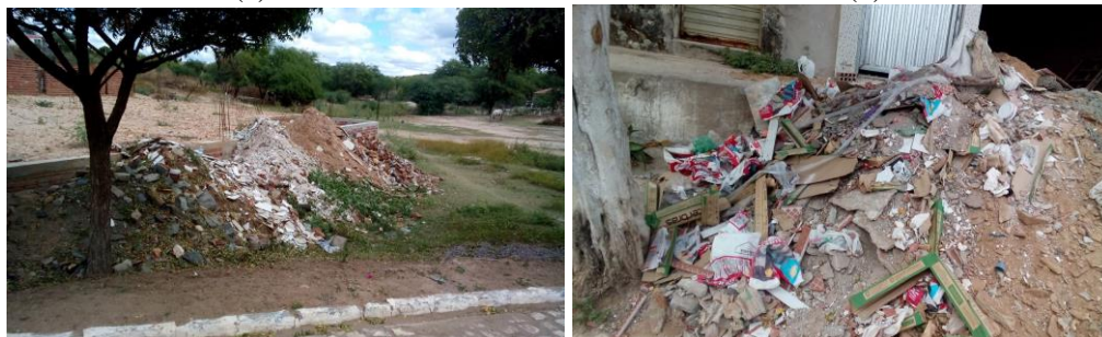
Figura 1. (a) Resíduos gerados em fase inicial de construção; (b) vários tipos de materiais misturados
